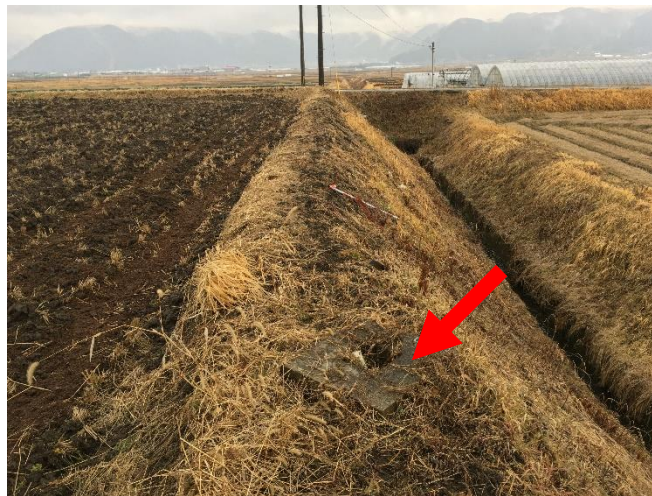
保護枠ずれ、柱石傾動
